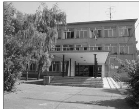
Základná škola na Biskupickej ulici.
