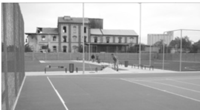
Športový areál Tryskáč tesne pred dokončením.
