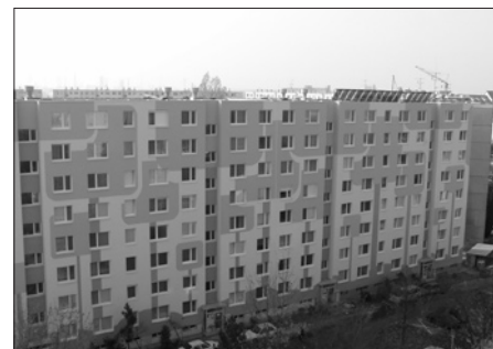
Náš dom po rekonštrukcii so slnečnými kolektormi na streche.
