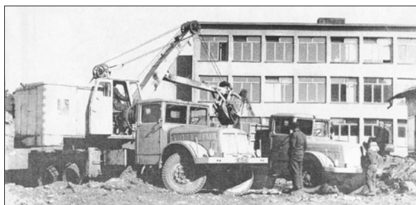
Z výstavby školy.
