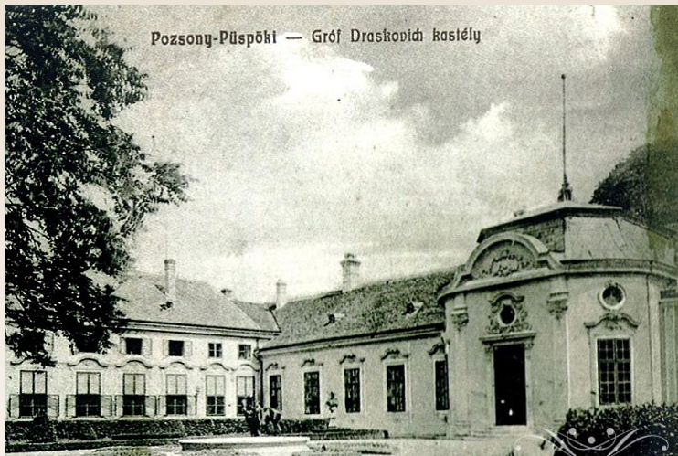
Hlavná budova a západné krídlo kaštieľa Ormosdyovcov začiatkom roku 1900, kedy už patrili rodine grófa Draskovicha.
