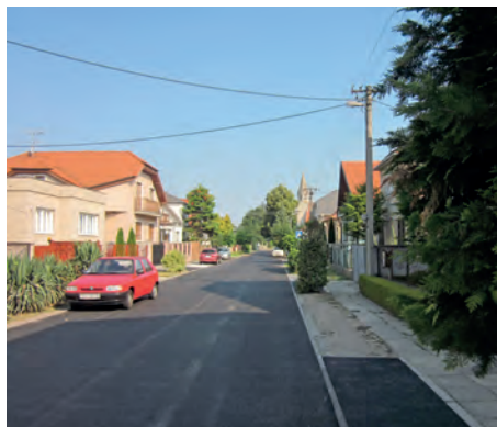
Dokončená výstavba kanalizácie na Odeskej ulici od križovatky Vetvárskej so Staromlynskou ulicou.
