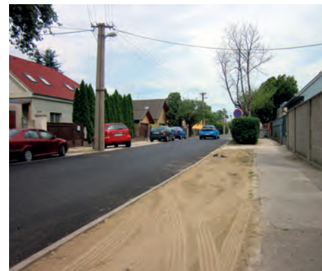
Aj Amurská ulica po dokončení kanalizácie opeknela.
