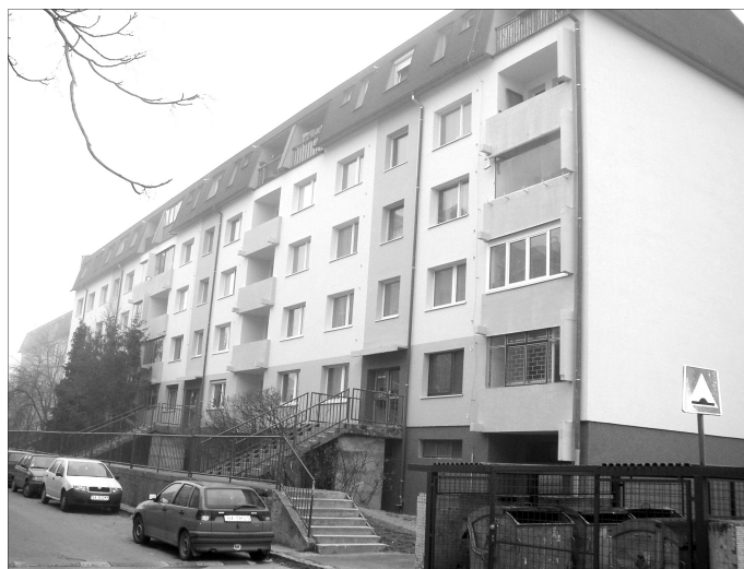
Dom na Latorickej ul. 8 - 12, zateplený technológiou Terranova-weber.
