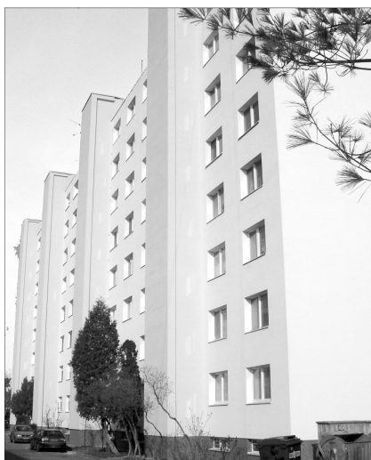
Dom na Lotyšskej ul. 26 - 32, ktorý bol zateplený kontaktným zatepľovacím systémom Multitherm.
