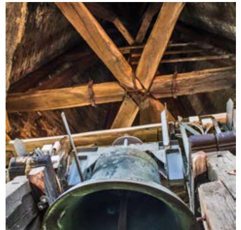
Pohľad do renesančnej murovanej helmice veže kostola.
