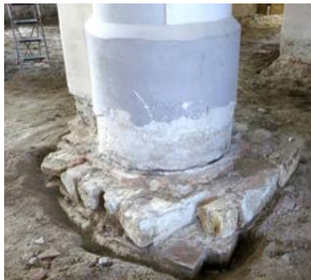
Kruhovú kamennú románsku pätku jedného zo štyroch stĺpov hlavnej lode znovaosadenú v 17. storočí na nový základ tvorený zdvojitým roštom z kamenných gotických rebier pôvodnej klenby kostola.
