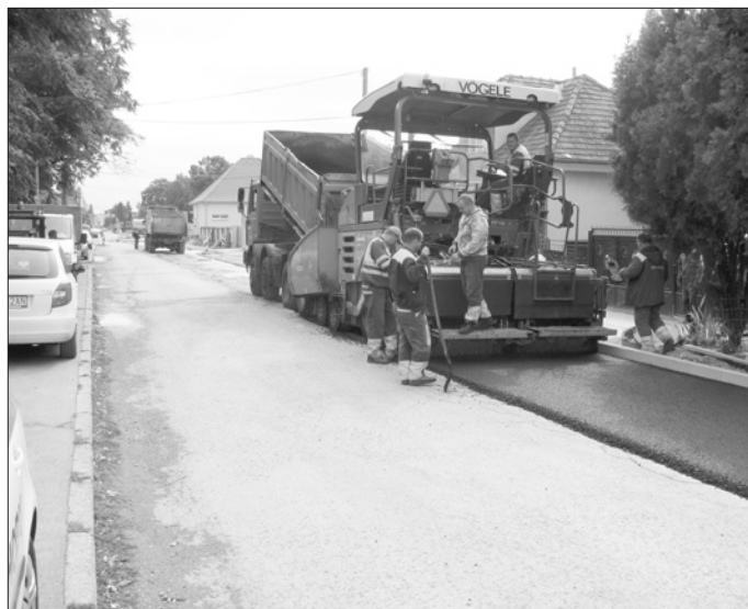
Pokládka asfaltového povrchu na Krajinskej ulici.
