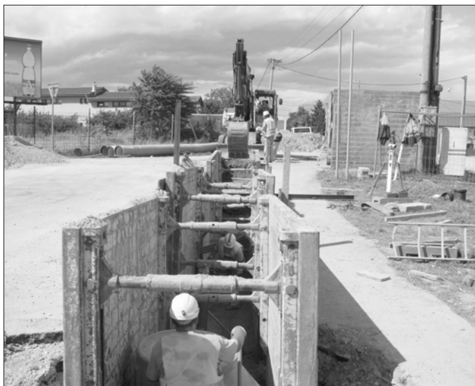
Ukladanie potrubia zberača v hĺbke 3,5 m na Popradskej ulici.
